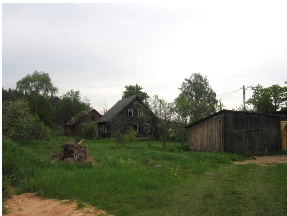
Vaade 4. Vaade kinnistu keskosast põhjapoolseks naabriks olevale Voolu kinnistule.
